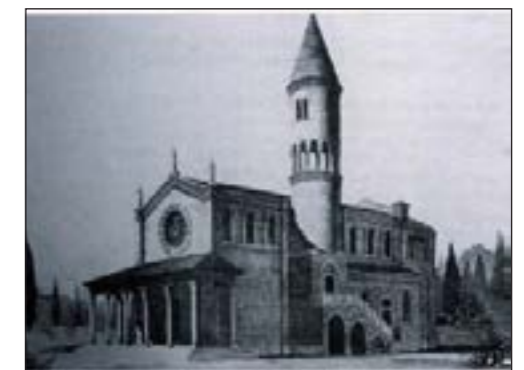
La Chiesa di Villanova appena costruita
